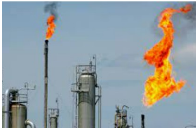
Tochas de Segurança de instalação industrial
