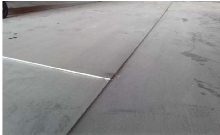
Instalação de novas chapas sobre fundo existente de um tanque
