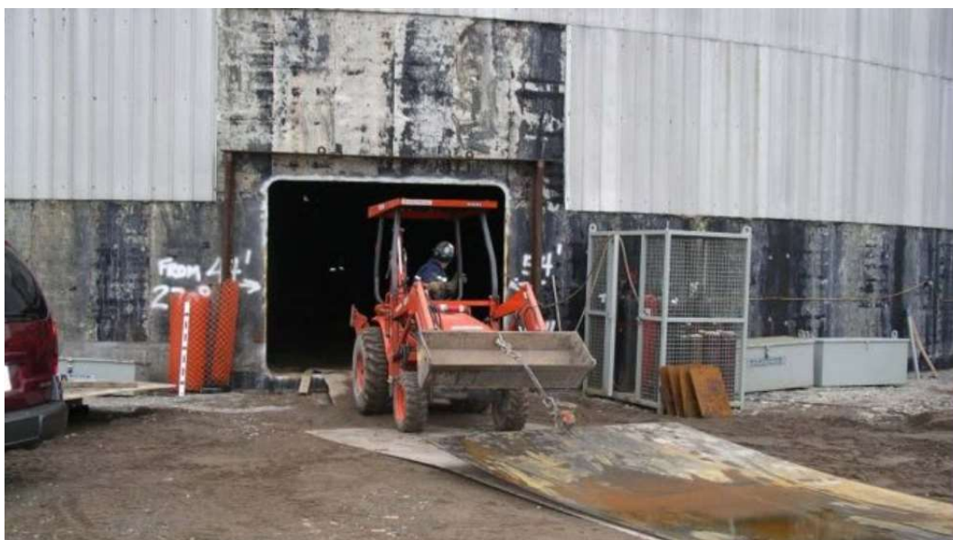
Abertura temporária no costado para acesso de material, máquinas e pessoal ao interior do ytanque
