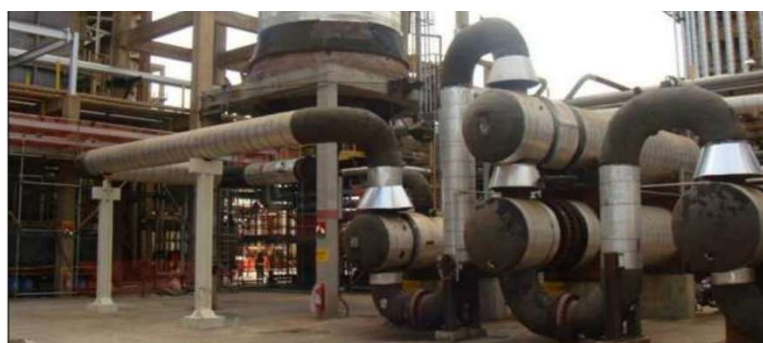
Ilustração do uso de capuz sobre ligações flangeadas de equipamentos em alta temperatura
