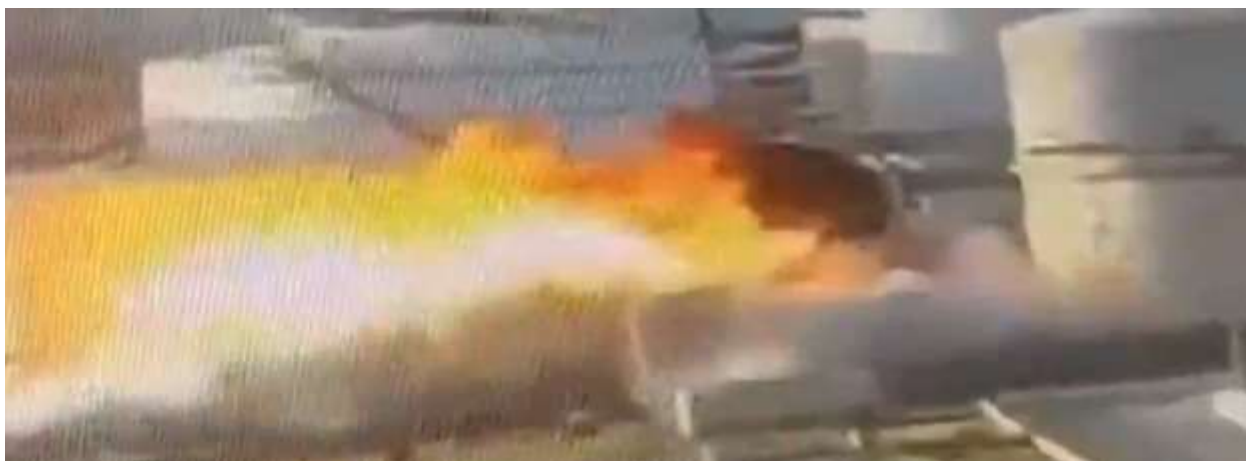
Foto Incêndio se alastrando em parque de tanques de uma Refinaria
