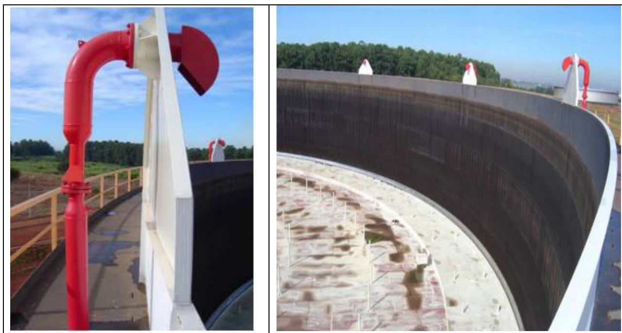
Figura: Descarga da espuma mecânica sobre o selo periférico no tanque de teto flutuante externo
