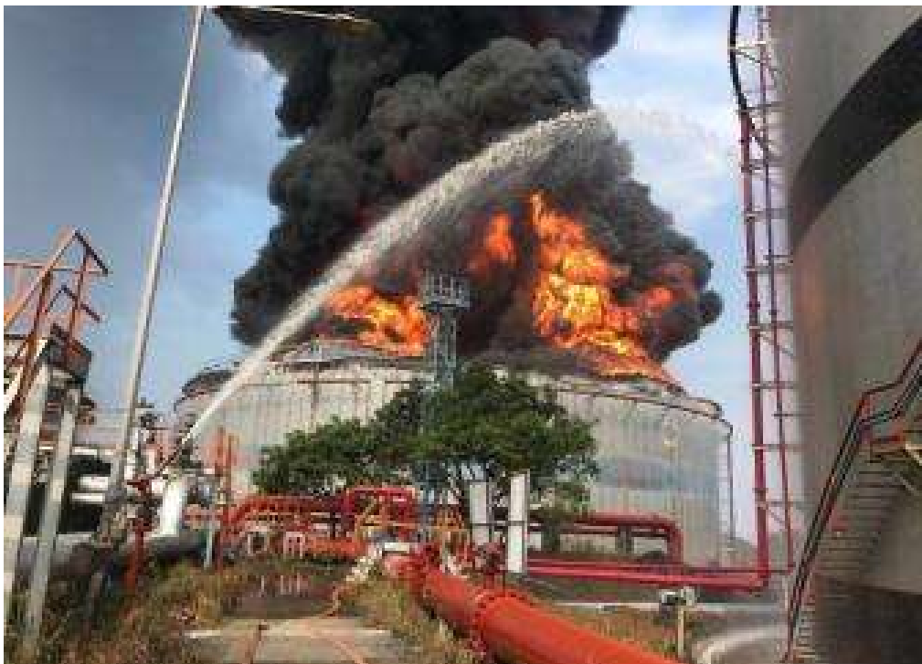
Figura: Canhão monitor fixo lançador de água para resfriamento de tanque
