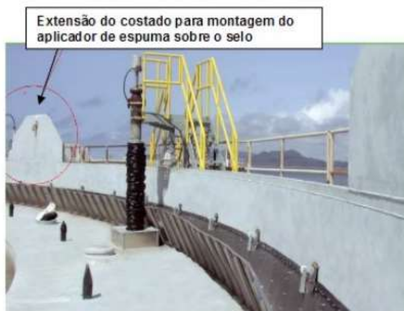
Foto da extensão do costado, do teto flutuante, para instalação do bocal injetor de espuma
